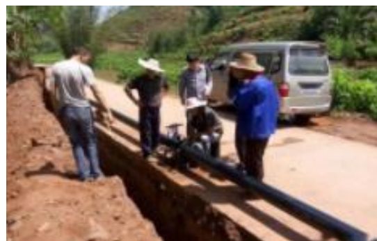
图1 农村供水工程建设
