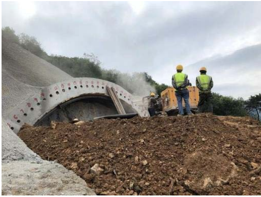
隧道管棚导向墙施工
